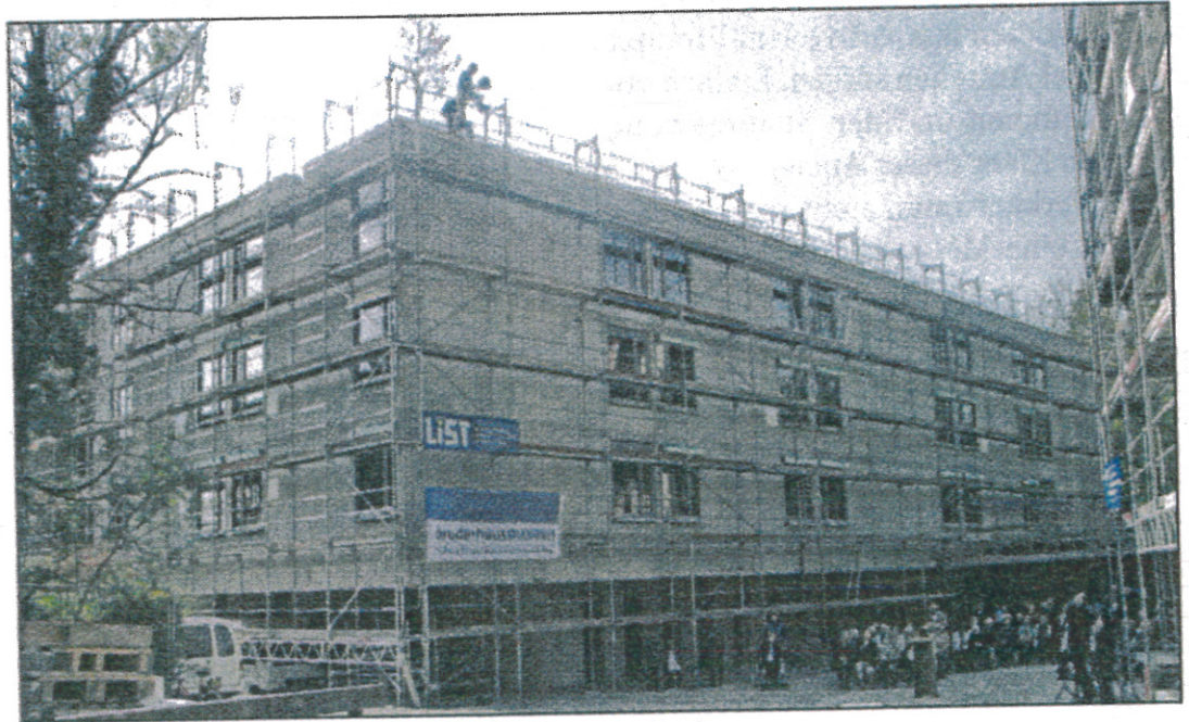
Gestern wurde Richtfest für die neue Villa Seckendorff in der Freiligrathstraße gefeiert. In acht Monaten sollen die Bewohner einziehen. Foto: Rehberger
